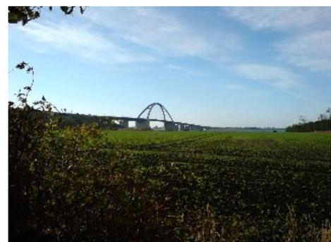
die Durchfahrtshöhe von 23 m im 240 m langen Hauptteil zu erzielen und den Eisenbahnbetrieb zu ermöglichen, waren zudem sehr lange Brückenauffahrten notwendig, weshalb über 1,3 Mio. m<sup>3</sup> Sand aufgeschüttet werden mußten.
